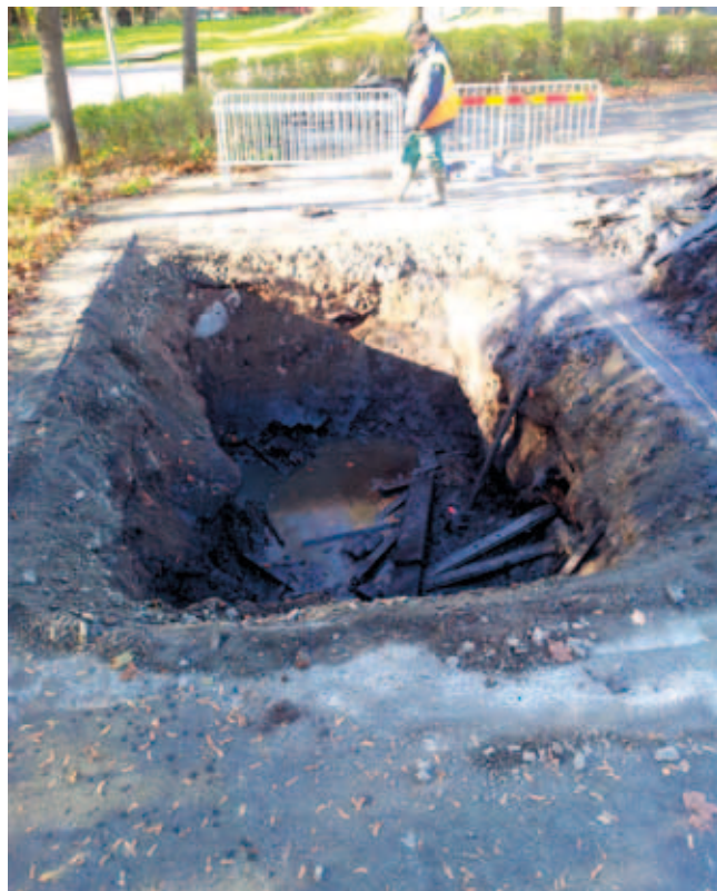
Illustration 26. Översikt över schakt 13, mot O. Rivningsmassorna från den senaste bebyggelsen är fyllda med oljebemängt vatten. Frågan om det fanns bevarade lämningar från Nya Lödöse kunde inte utredas här.
